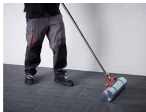
Flächiges Andrücken aller Dielen mit einer Anpresswalze.
