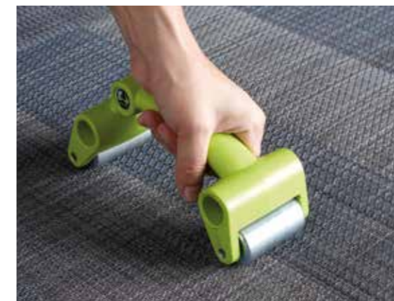
Die Anschlüsse mit einem Nahtroller fest anpressen.
