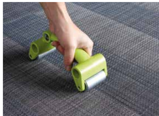
Die Anschlüsse mit einem Nahrroller fest anpressen.
