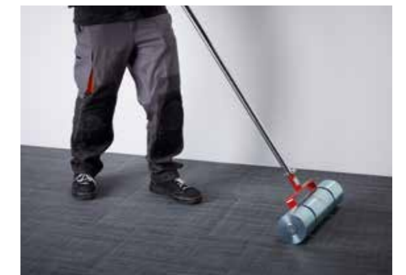
Flächiges Andrücken aller Dreiecke mit einer Anpresswalze.
