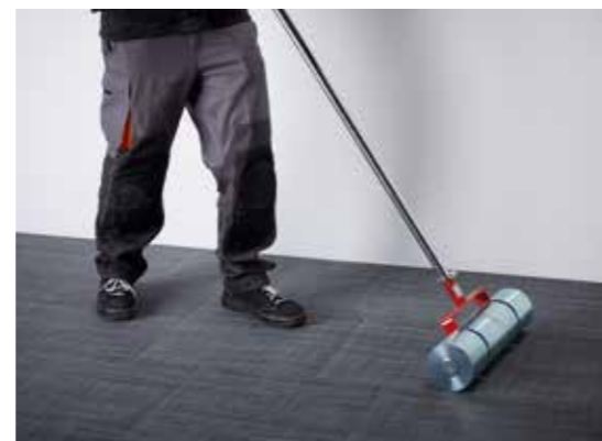
Flächiges Andrücken aller Prismen mit einer Anpresswalze.
