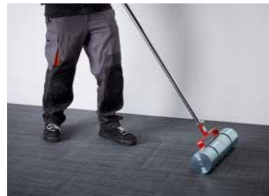
Flächiges Andrücken aller Halb-Sechsecke mit einer Anpresswalze.
