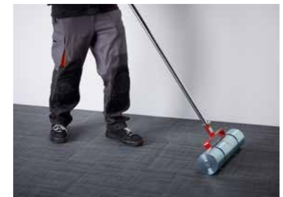
Flächiges Andrücken aller Formen mit einer Anpresswalze.
