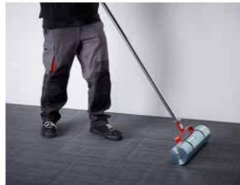
Flächiges Andrücken aller Fliesen mit einer Anpresswalze.
