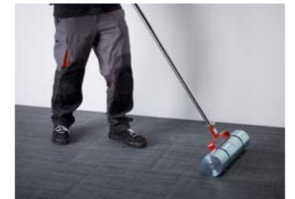
Flächiges Andrücken aller Gammas mit einer Anpresswalze.
