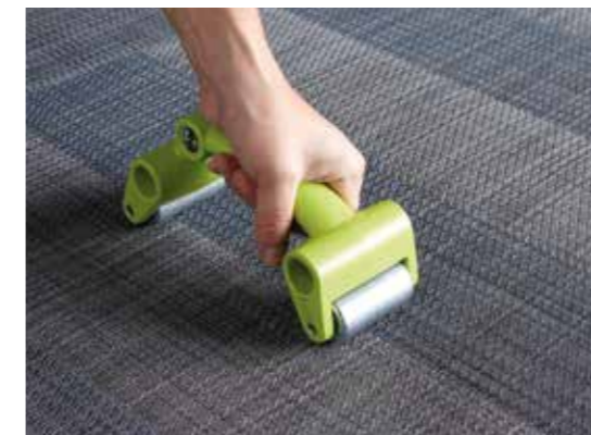
Die Anschlüsse mit einem Nahrroller fest anpressen.
