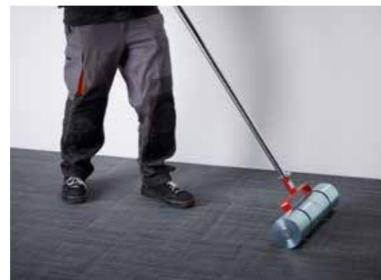
Flächiges Andrücken aller Formen mit einer Anpresswalze.
