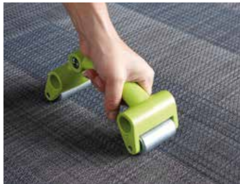
Die Anschlüsse mit einem Nahtroller fest anpressen.
