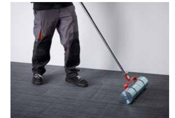
Flächiges Andrücken aller Sechsecke mit einer Anpresswalze.
