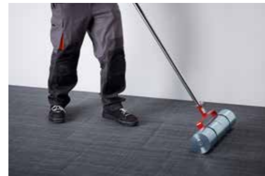
Flächiges Andrücken aller Fliesen mit einer Anpresswalze.
