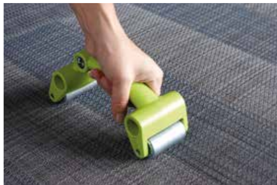
Die Anschlüsse mit einem Nahtroller fest anpressen.
