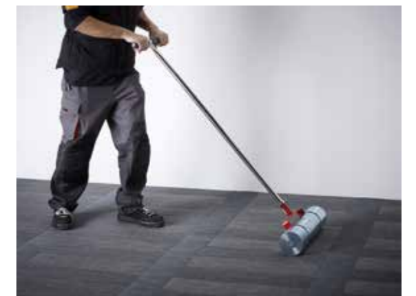
Flächiges Andrücken aller Fliesen mit einer Anpresswalze.
