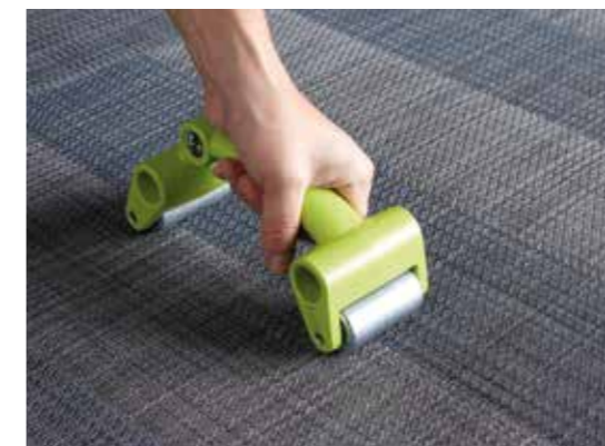
Die Anschlüsse mit einem Nahtroller fest anpressen.
