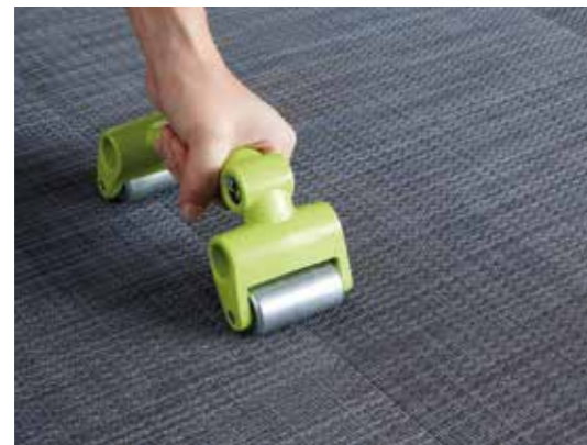
Die Anschlüsse mit einem Nahtroller fest anpressen.
