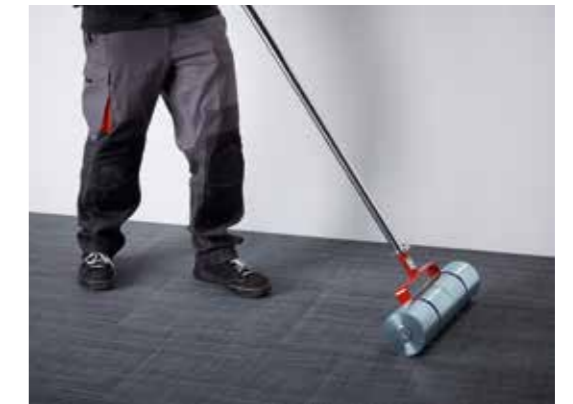
Flächiges Andrücken mit einer Anpresswalze.
