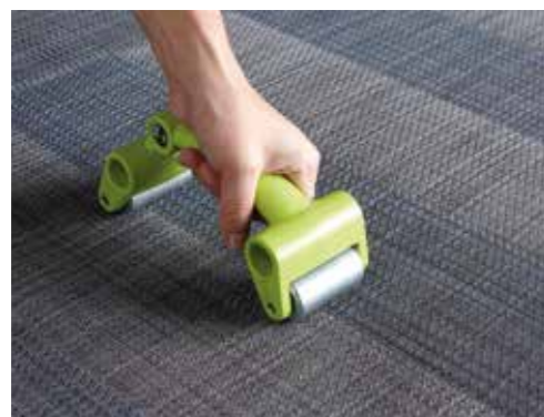
Die Anschlüsse mit einem Nahtroller fest anpressen.
