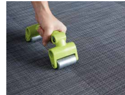
Die Anschlüsse mit einem Nahtroller fest anpressen.
